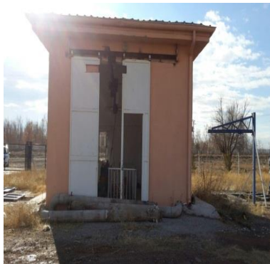
ARATOL KANALİZASYON TM (BETONARME)
