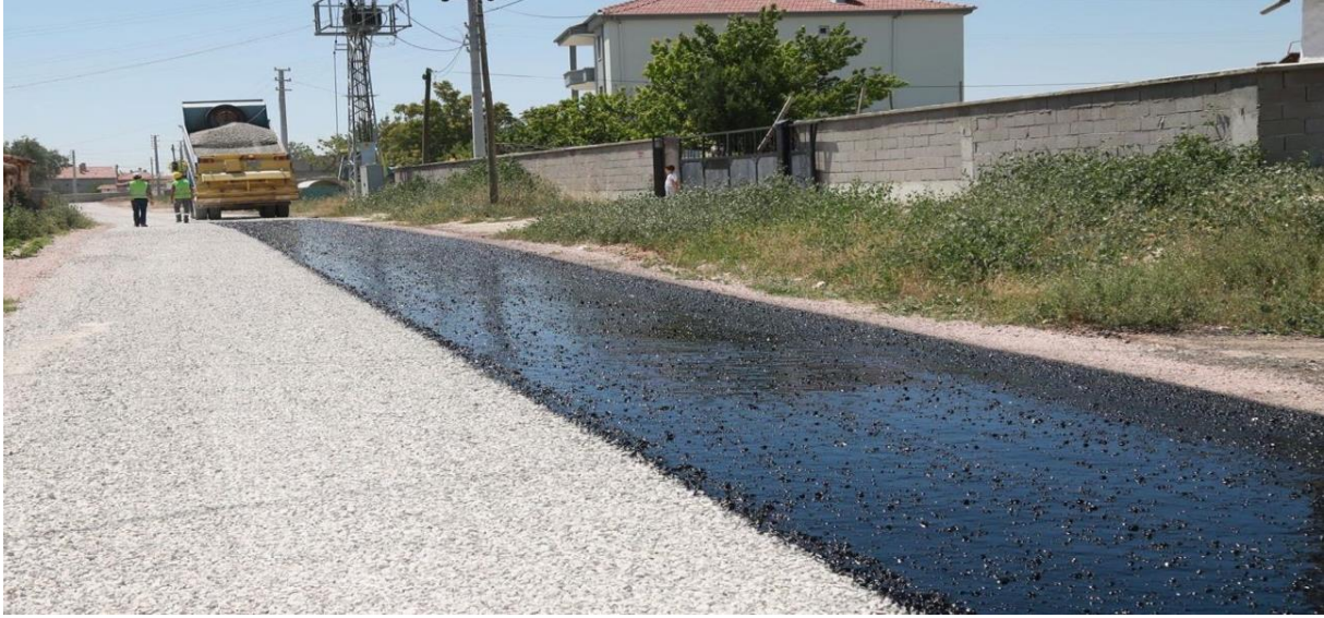
Sathi Kaplama uygulaması
